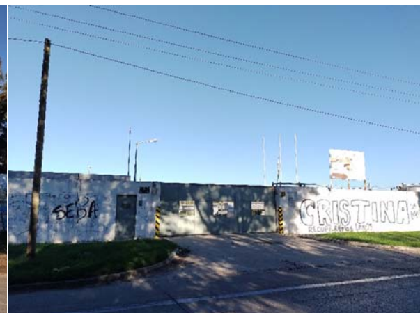
Figura 12: Olazabal 5460. Acceso a la Planta Depuradora Lanús de AySA
